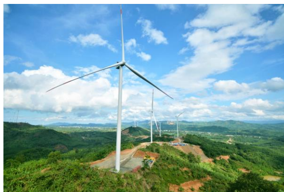
Dự án điện gió trên bờ tại Quảng Trị - Ảnh chụp tháng 7/2021
