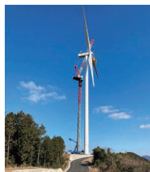
ブレード搬入の様子 (2025年12月)
