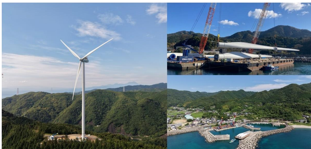
(荅北・天草風力発電所 建設地及び建設風景)
