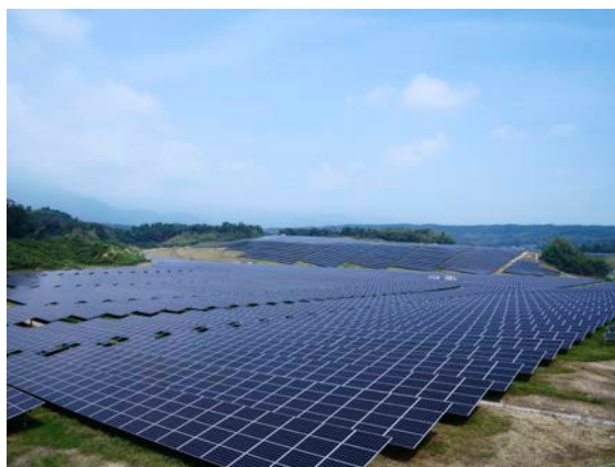
（四日市ソーラー発電所）
