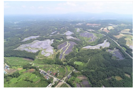
<軽米西ソーラー発電所 全景>
