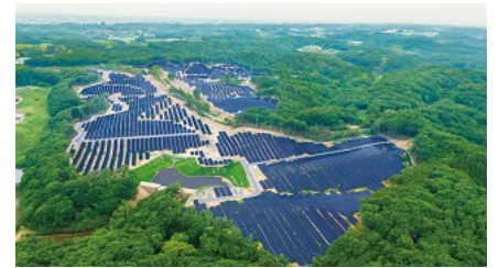
<那須烏山ソーラー発電所 全景>
