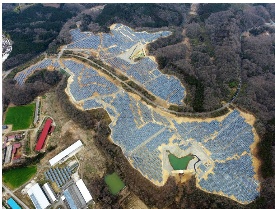
「那須烏山ソーラー発電所」全景
