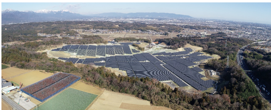
「四日市ソーラー発電所」全景
