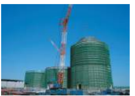
2021年6月の運転開始を目指し建設中の秋田バイオマス発電所(福岡県)。設備容量75MWと国内最大級
