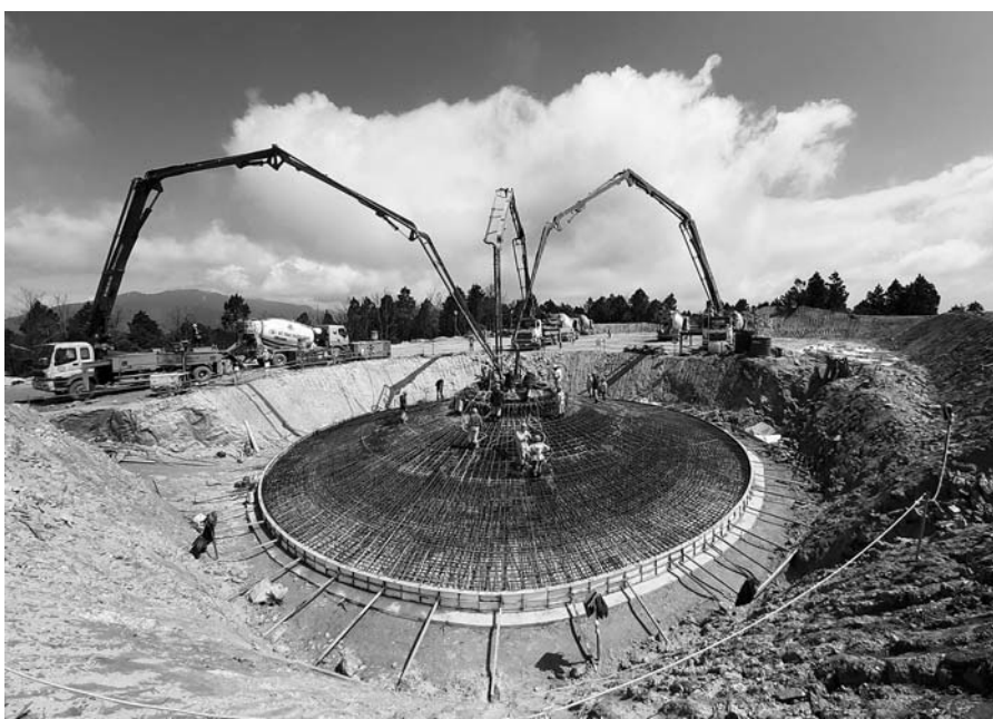
クアンチ陸上風力発電(ベトナム)の建設現場
